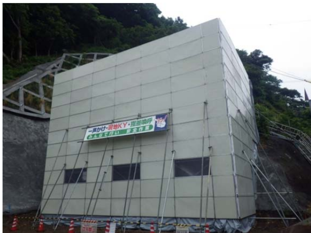
写真-2 坑口部防音パネル建屋
