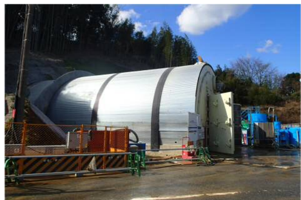
写真-4 防音シェルター
