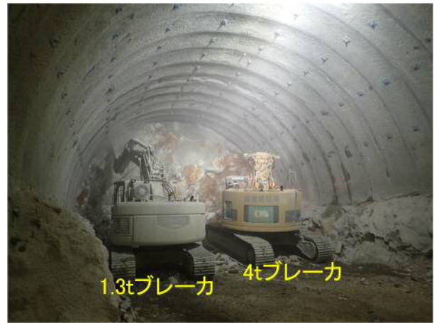
写真-3 ブレーカによる掘削状況
