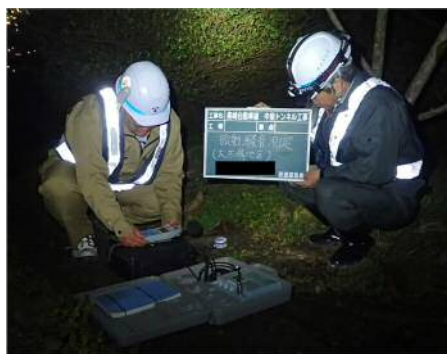
写真-7 騒音、振動測定状況(トンネル直上住居付近にて)
