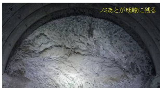
写真-5 切羽状況（硬質な砂岩）
