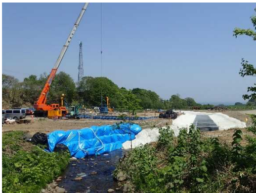
(a) 切回し水路と高圧噴射攪拌工法の作業ステージ
