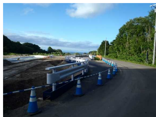
(d) 切回し道路施工状況
