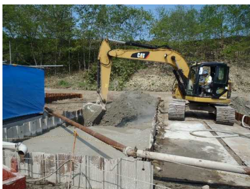
(c) スラリーピット排泥処理状況
