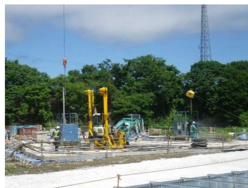
(b) 高圧噴射攪拌工法の施工状況
