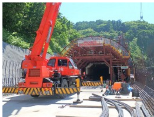
写真-6 シート台車を利用した鉄筋組立
