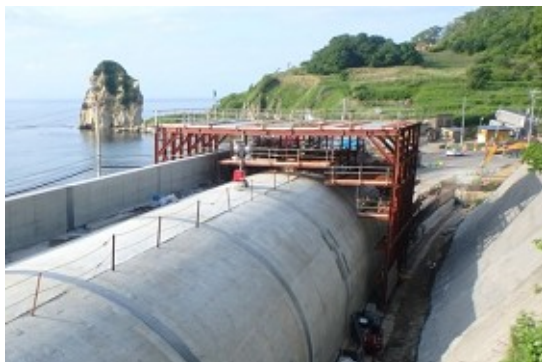
写真-13 移動足場でのPコン処理
