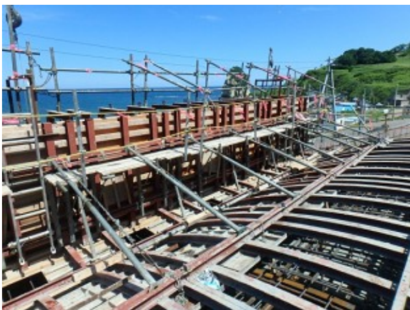
写真-10 アウトセメントル擁壁内側
