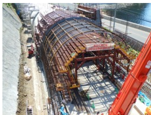
写真-7 鉄筋支保工と内筋組立
