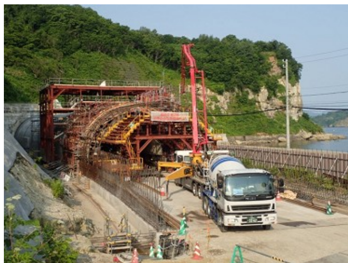
写真-11 コンクリート打設状況
