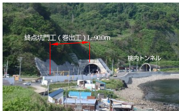
写真-2 終点坑門工（巻出工）施工箇所
