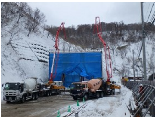
写真-14 移動足場を利用した冬期養生状況
