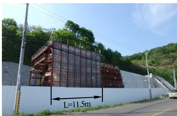
写真-5 作業足場・養生上屋側面
