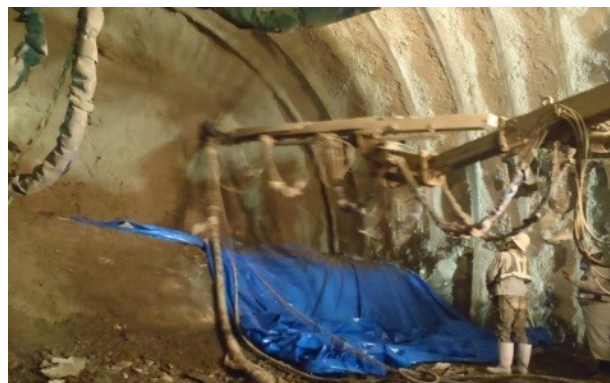
写真-4 はね返り率試験状況 (1)
