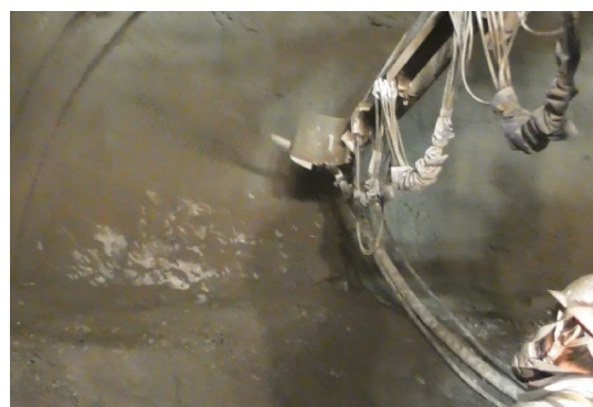
写真-3 吹付けコンクリート実験状況
