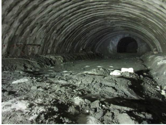
写真-2 盤打ち発破後の坑内状況
