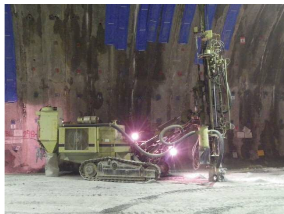
写真-1 油圧クローラードリルによる穿孔状況
