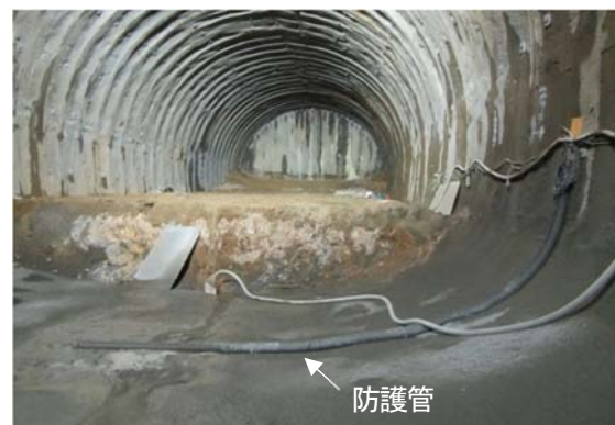
写真-2 インバート吹付け上への設置状況
