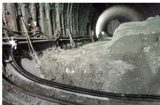
写真-3 インバートストラットへの設置
