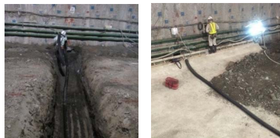
写真-4 路盤下への設置
