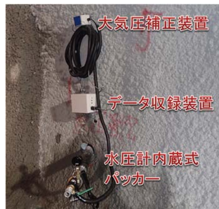
写真-8 短尺スイリモの設置状況
