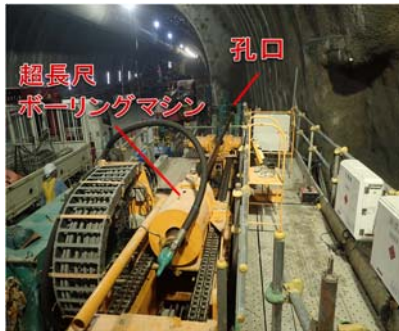
写真-1 超長尺ボーリング実施状況
