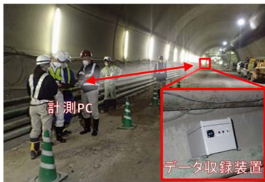
写真-6 トンネル坑内通信試験
