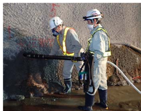
写真-7 短尺スイリモの挿入状況
