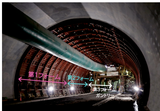
写真-1 TrAF工法の施工状況
