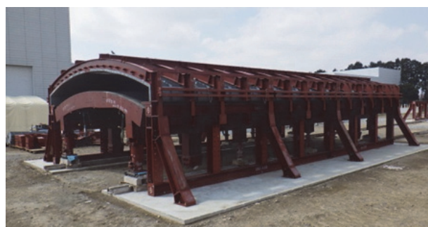
写真-1 型枠外観
