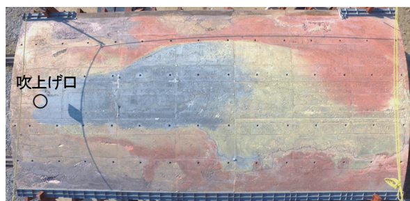
写真-7 硬化後充填状況（改善実験1）
