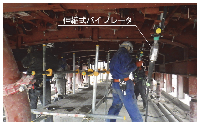
写真-11 伸縮式バイブレータ使用状況
