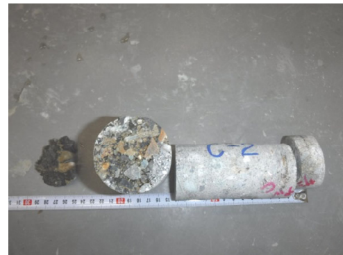
図-12 コア外観状況
