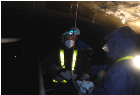
図-11 アクリル樹脂注入状況
