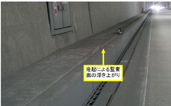
写真-1 監査廊の浮き上がり状況
