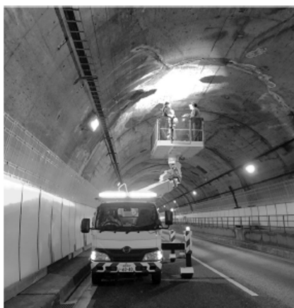
写真-2 近接目視、打音点検状況
