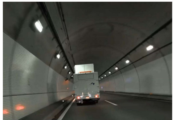
写真-1 覆工表面撮影車両による撮影状況
