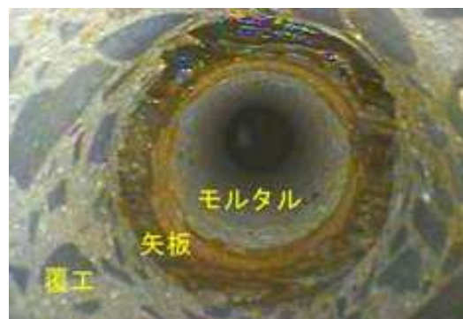
写真-3 削孔空洞調査孔内状況の例
