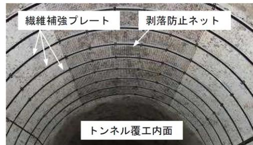
図-1 バサルト帯板接着工法の施工例
