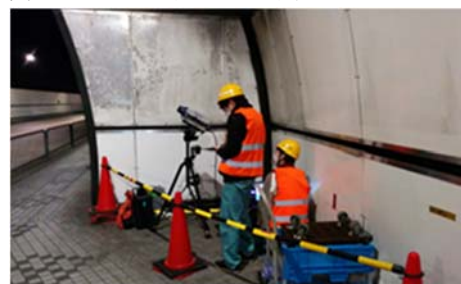
写真-3 トンネル内での計測状況
