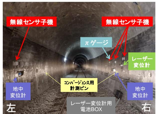
図-10 モニタリング機器の設置状況 (全体写真)
