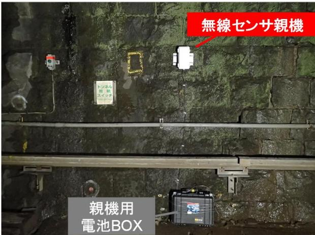
図-11 44k081m付近左側親機設置状況
