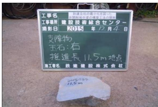
写真-3 地盤切削機構により切断された支障物
