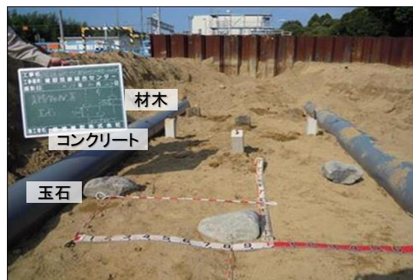
写真-2 支障物設置状況
