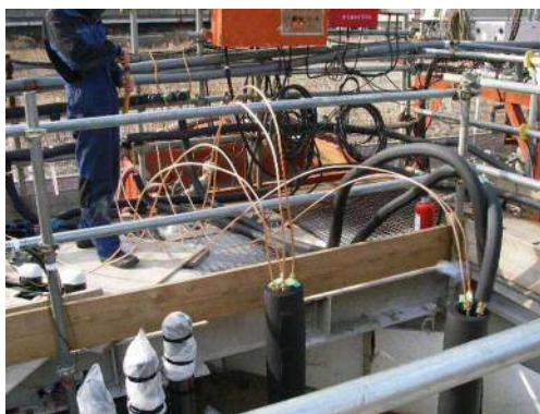
図-9 鉛直凍結管
