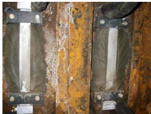
図-10 貼付凍結管
