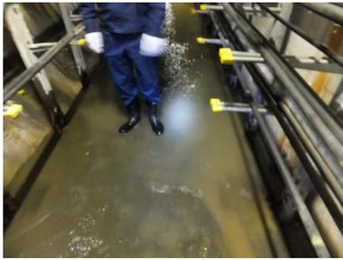
図-2 トンネル内への水の浸入 (東京)
