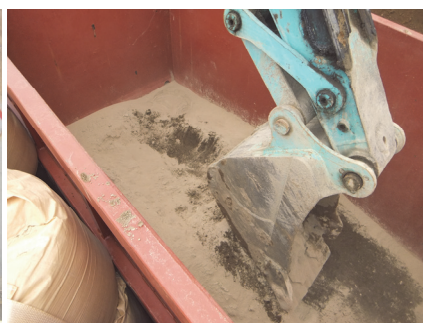
(b) 現地土、人工粘土混合
