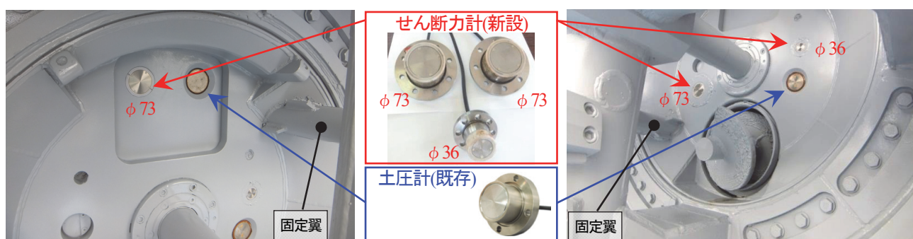
写真-3 セン断力計, 土圧計 設置状況
