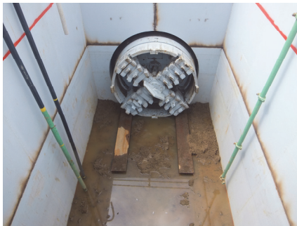
(a) シールド通過架台、底盤作製
