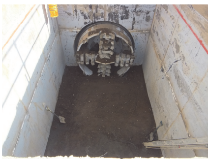
(a) シールド通過架台、底盤作製
