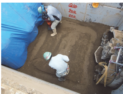
(d) 撒出し、転圧
