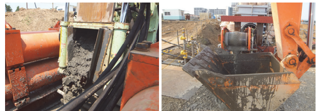
(a) IV-0(加泥材なし) (b) IV-1(加泥材 A) 写真-6 砂質土排土状況
