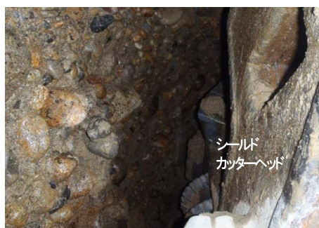
図-2 シールド掘削対象地盤（砂礫）の例
