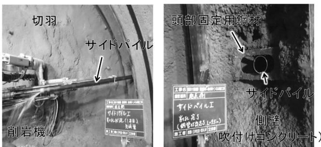
写真3 サイドパイル工の施工状況
