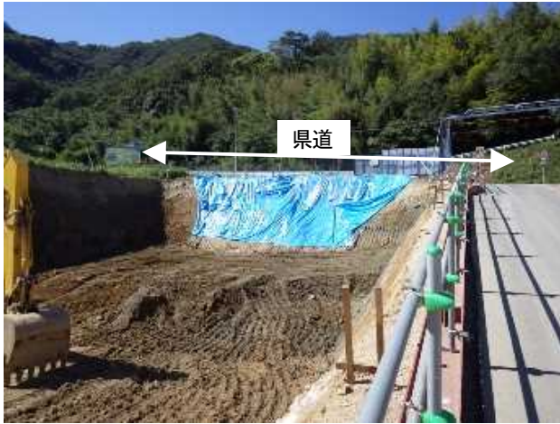
写真-1 東側坑口付近の状況（坑口付け切土の段階）
