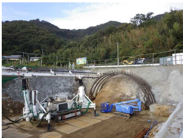
写真-2 トレヴィチューブ工法打設状況
