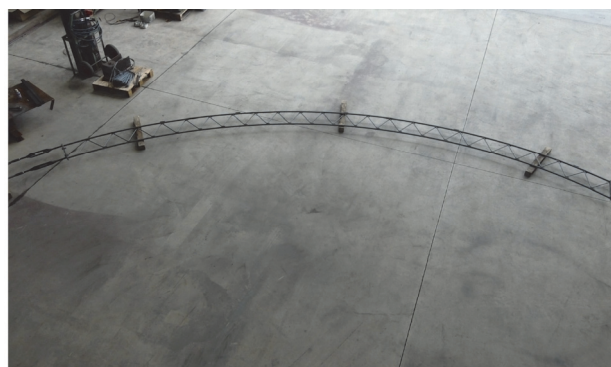
写真-3 アーチ部鉄筋組立用仮設鋼材
