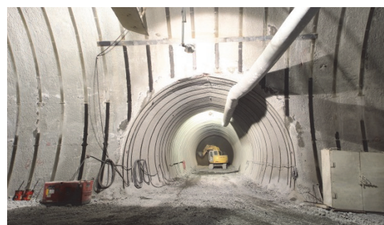
写真-1 交差部支保工設置状況
