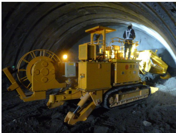
写真-4 掘削状況 (ロードヘッド)
