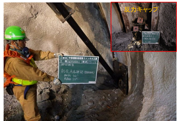
写真-6 レッグパイル打設状況
