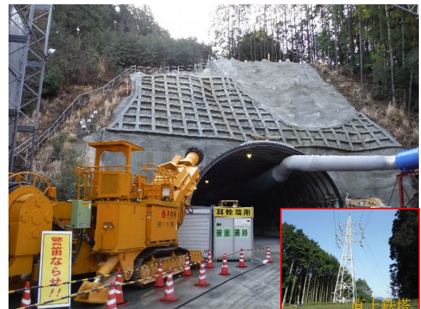
写真-1 トンネル施工状況 1)
