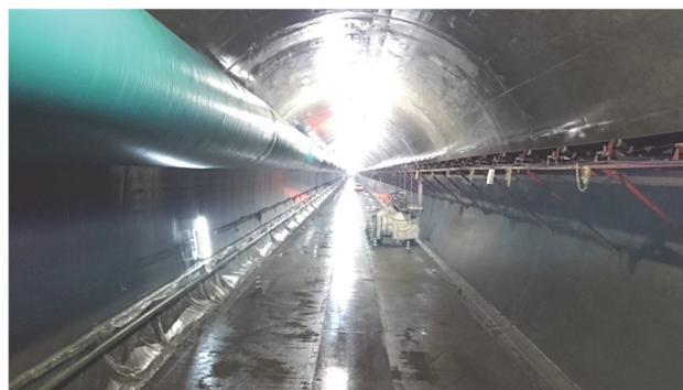
写真-1 高充填コンクリートで施工した覆工（奥野々）
