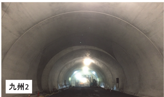
写真-2 高充填コンクリートを用いた覆工の仕上がり
