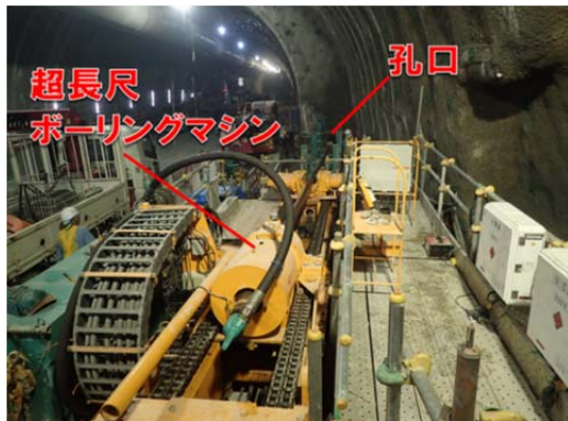
写真-2 超長尺ボーリング実施状況
