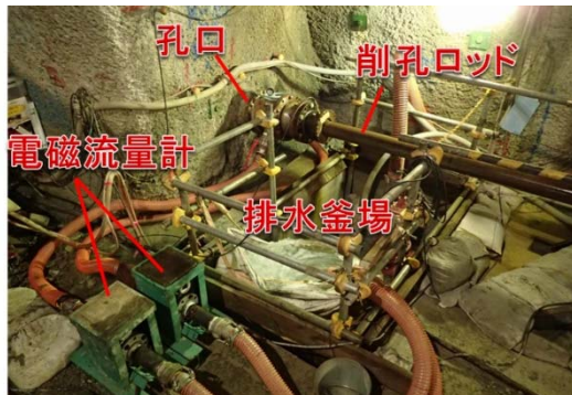
写真-3 超長尺ボーリング実施状況 (孔口付近)
