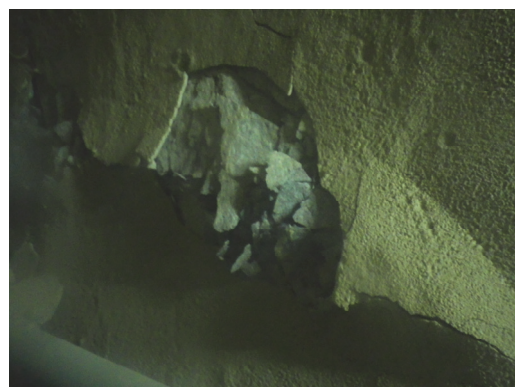
写真-5 吹付けによる山はね飛石防止
