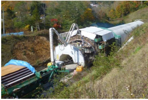
写真-8 打設状況
