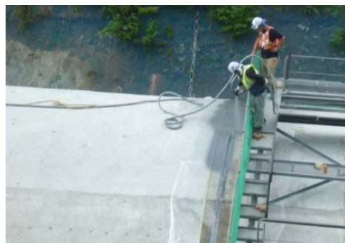
写真-7 ウレタン外防水施工状況
