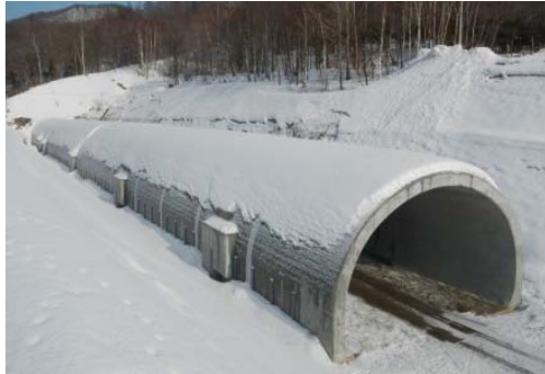
写真-9 躯体の構築状況
