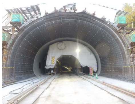
写真-4 吊鉄筋方式組立完了
