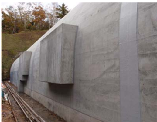
写真-6 背面突出部完成
