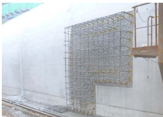
写真-5 チッピングと配筋状況
