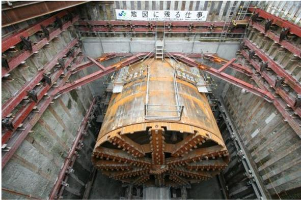
写真-3 西谷方立坑到達後のシールド
