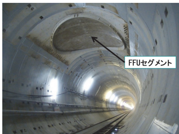
写真-3 上向きシールド発進部
