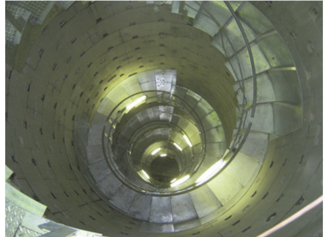
写真-7 WB 1分岐立坑シャフト部全景
