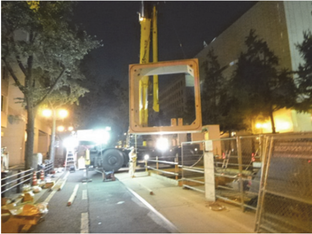
写真-6 プレキャストボックス据付状況
