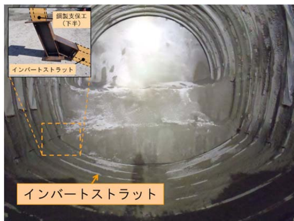
写真-2 インバートストラット施工状況
