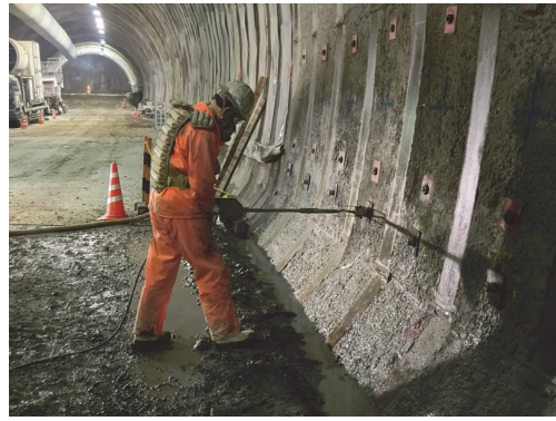
写真-3 挿入した内管の加圧膨張状況
