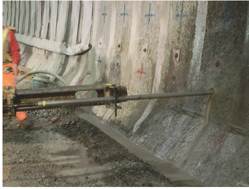
写真-2 ドリルジャンボによる二重管式膨張型 ロックボルトの打設状況
