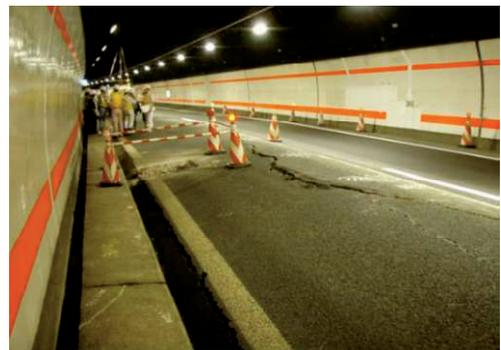
図-1 盤膨れ発生状況
