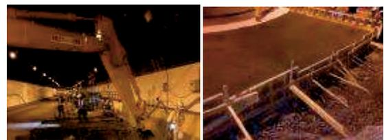
図-8 通行止めによるコンクリートインバート
