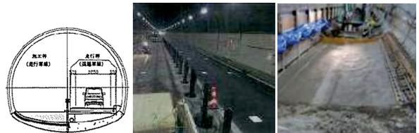
図-9 車線規制によるコンクリートインバート（左右分割）
