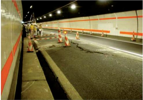
のような盤膨れへの対策としてのインバートの追加設置（以後「インバート補強」という）や，外力による変状に対する覆工補強が特定更新等工事の内容となっている．
