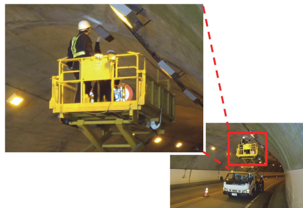
写真-1 従来型レーダ探査状況
