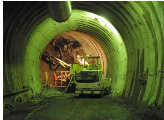
写真-3 拡幅掘削(作業坑より臨む)
