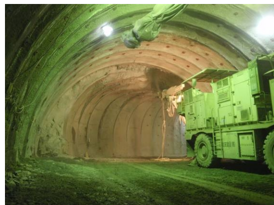
写真-4 切詰め掘削(本坑より臨む)
