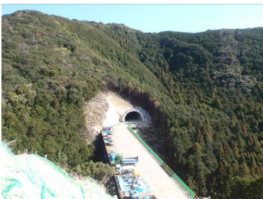
写真-1 起点側坑口の状況
