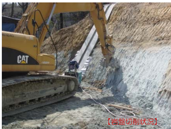
写真-10 ツインヘッドによる掘削状況
