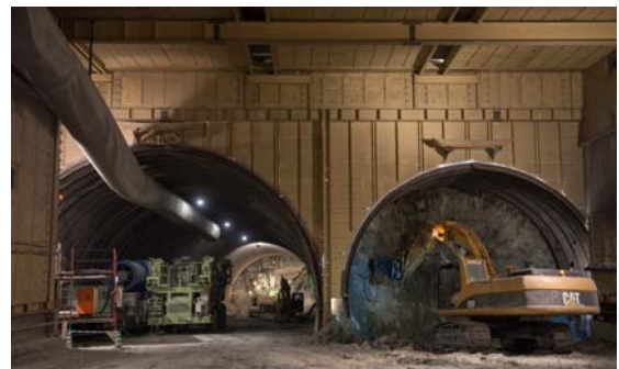
写真-1 トンネル施工状況
