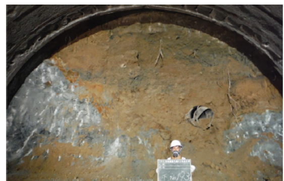
写真-9 既設排水管出現状況（先進坑）
