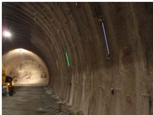
写真-8 光る変位計設置状況（干渉部）
