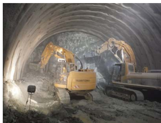
写真-4 掘削状況（下り線 DⅠ区間）
