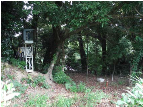
写真-7 地表面沈下自動計測状況
