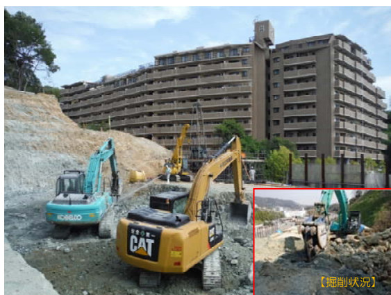
写真-11 エキセントリックリップパ掘削状況
