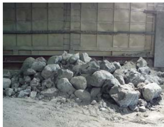
写真-3 硬質の玉石出現状況（沢部通過時）
