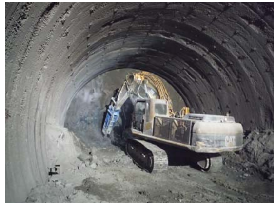
写真-6 上り線（D I S）掘削状況
