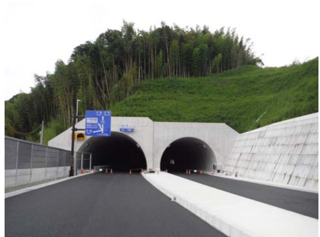
写真-14 起点側坑口部 全景
