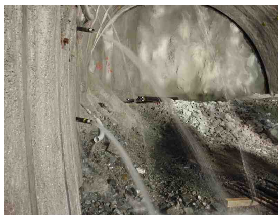
写真-3 水抜きボーリングからの排水状況
