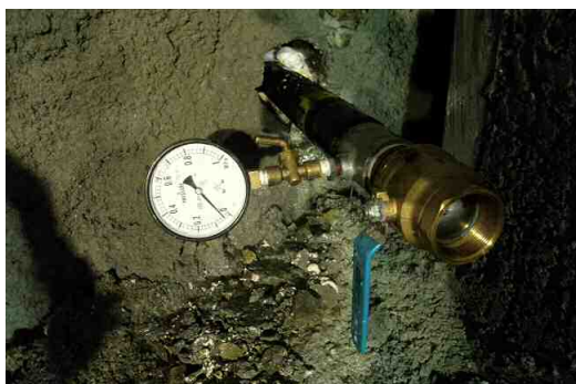
写真-5 水圧測定状況
