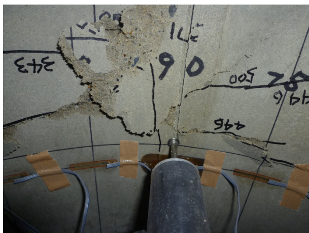
(a) 荷重500 kNにおける天端付近の様子
