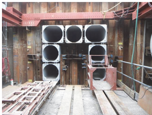
写真-1 箱形ルーフ設置完了状況
