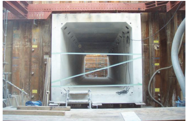
写真5 函体設置完了状況
