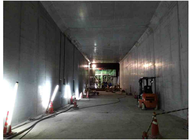
写真-7 施工完了状況
