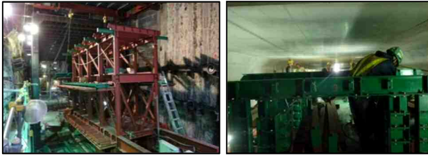
写真-6 カルバートスライドセントル組立み・改造状況
