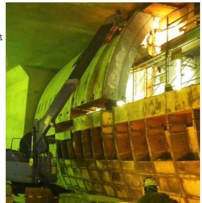
写真-1 鋼殻撤去状況
