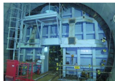
写真-5 ②仮壁
