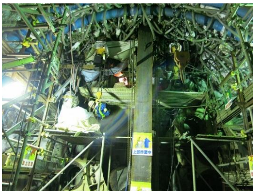
写真-2 下流側シールド鉛直支保工
