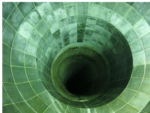
写真-6 地中接合部
