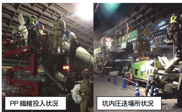
写真-2 施工状況
