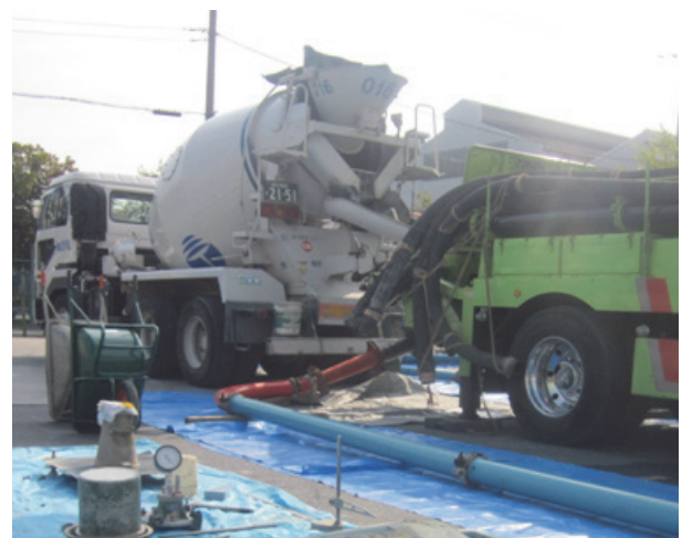
写真-1 施工実験の状況
