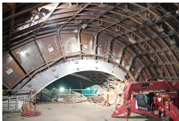
写真-5 拡大シールド部接続完了
