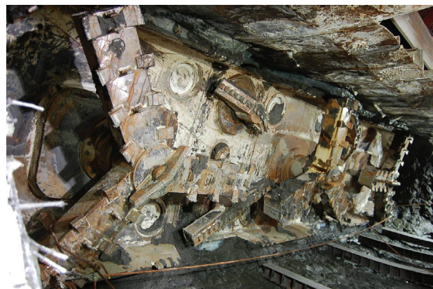
写真-4 拡大シールド到達状況
