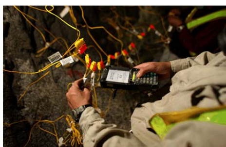
写真-3 切羽でのスキャン状況
