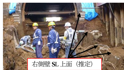
図-3.12 E-E位置(62k780m付近)のトンネル部開削状況
