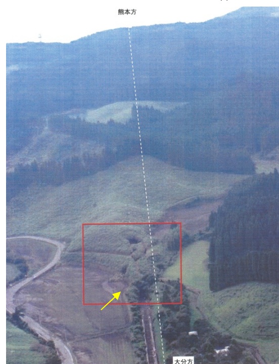
図-3.15 大分方坑口付近の状況(2)
