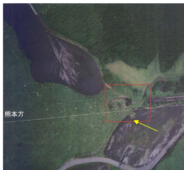
図-3.14 大分方坑口付近の状況(1)
