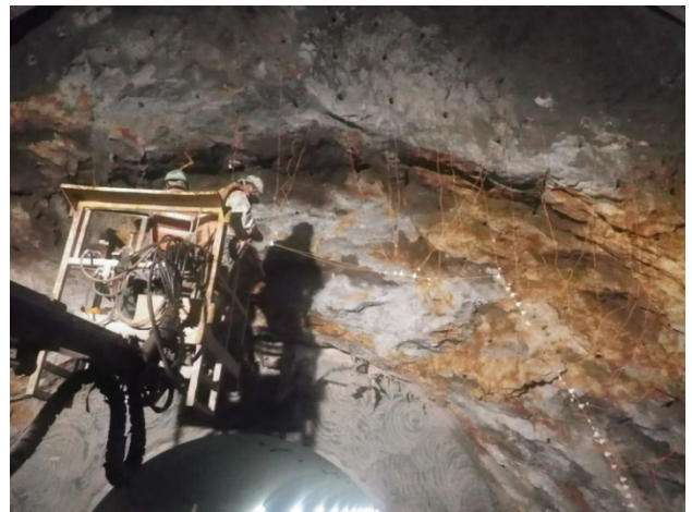
写真-1 非火薬破砕剤の破砕・結線状況
