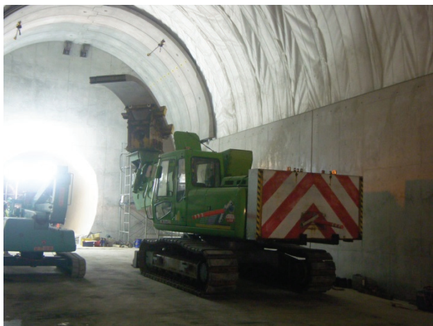
写真-2 PCL版設置状況
