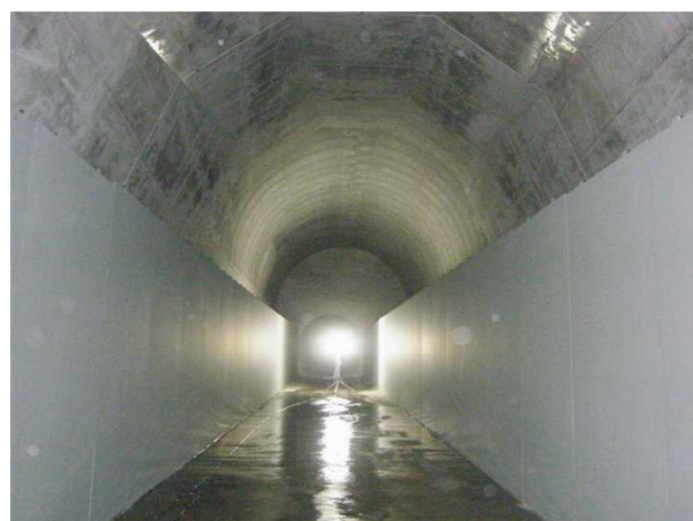
写真-3 完成したトンネル
