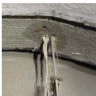
(a) センサー設置孔の削孔
